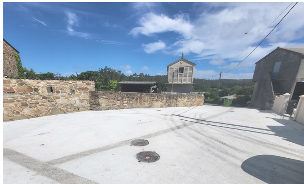
Resultado dos traballos de pavimentación no núcleo de Colúns.
