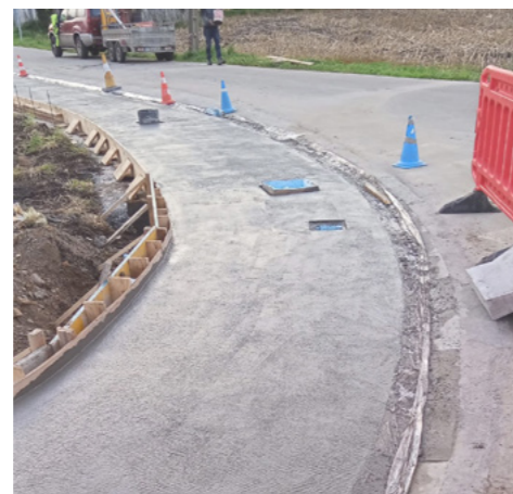
Obras de construción de beirarrúas
